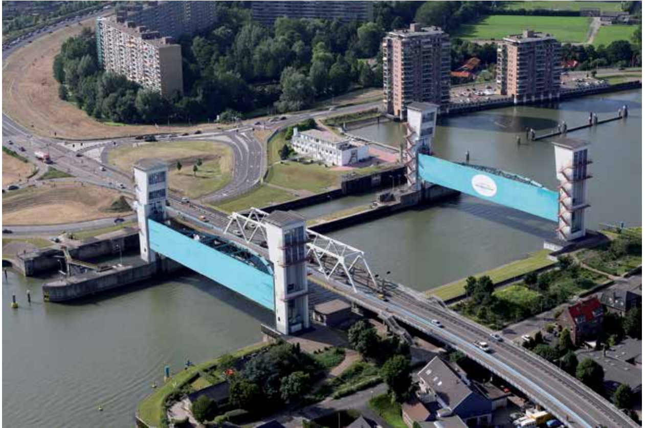
27 | De waterkering in de Hollandsche IJssel
