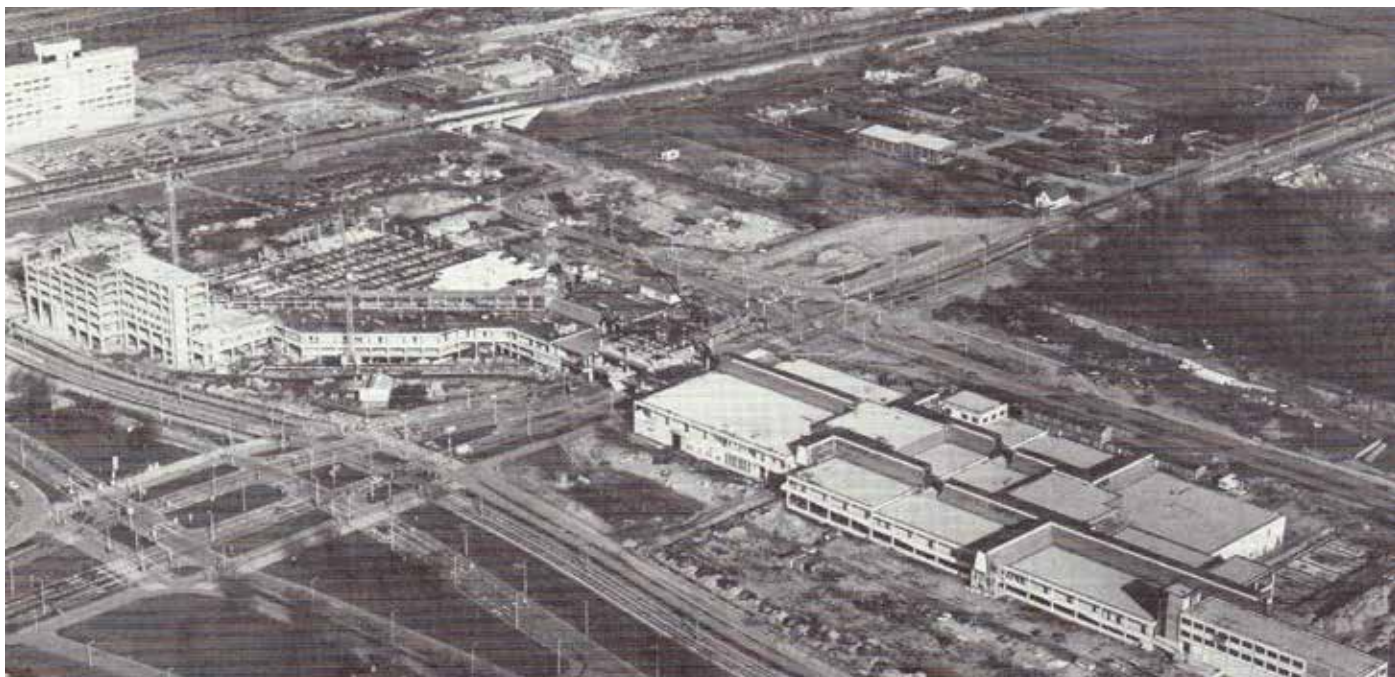
De Oosterhof in aanbouw.
